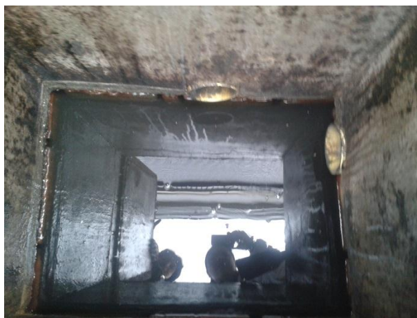
Foto No. 3. Caja de inspección externa KR 43 A
